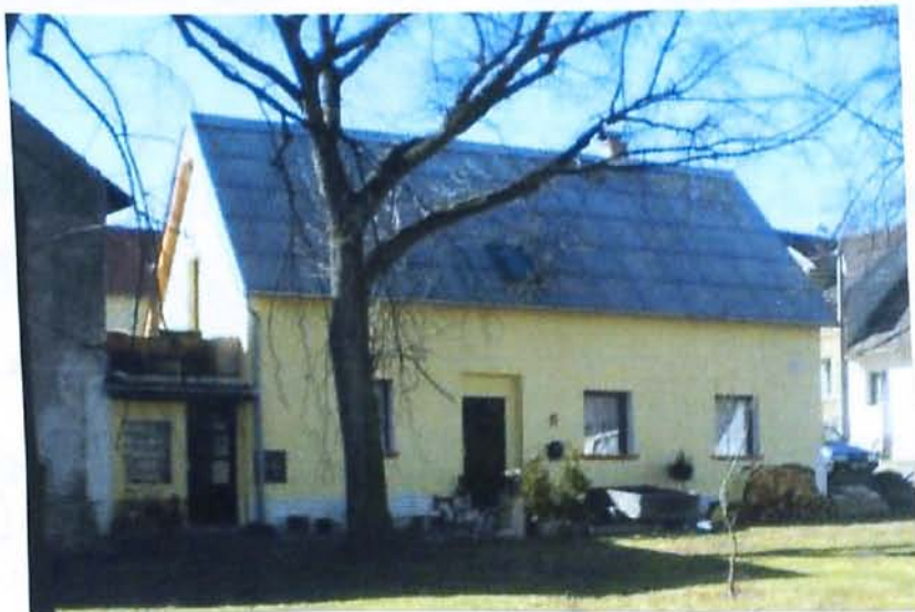
Náves - původní obecní úřad po rekonstrukci
